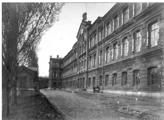
ХТИ, Главное здание
