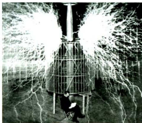
Рис. 10. Внешний вид мощного высоковольтного резонансного трансформатора Теслы (на стуле рядом с трансформатором и искрами сидит сам автор этого изобретения) [2, 3]
