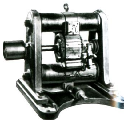
Рис. 18. Электрическая машина Грамма [3]
