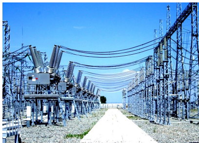
Рис. 13. Внешний вид оборудования современной мощной подстанции, преобразующей электроэнергию в соответствии с требованиями ее различных потребителей [13, 18]
