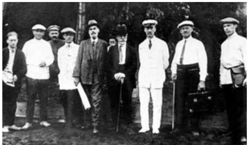
Начало строительства электротехнического корпуса. В центре известный академик архитектуры А. Н. Бекетов
