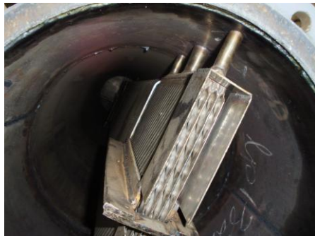
Рис. 6– Парно сваренные пластины разборной греющей камеры
