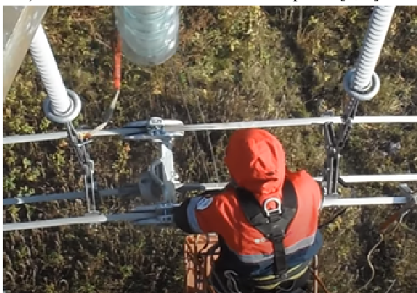
Рис. 1. Виконання НЕК «Укренерго» ремонтних робіт на ЛЕП 330 кВ без зняття напруги
