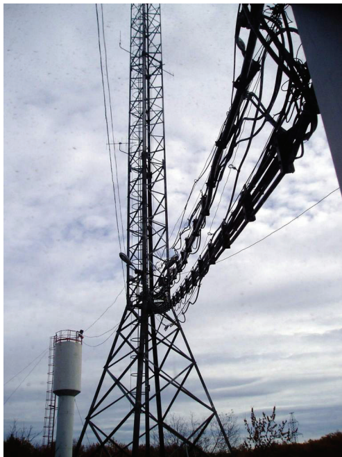
Рисунок 1 – Мачта связи на территории ЛПУ магистральных газопроводов
