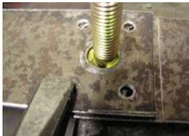
Рис. 7 – Разобранный болтовой крепеж с выбранным зазором
