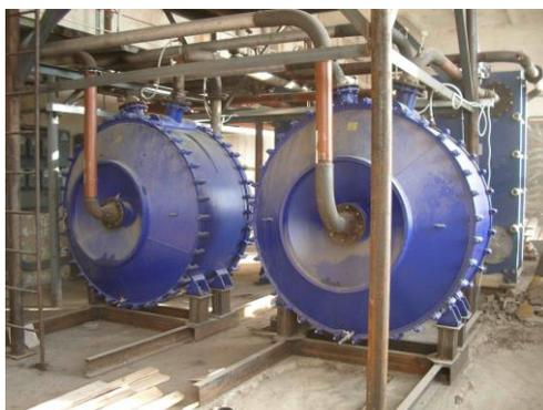
Рисунок 5 – Спиральные и ширококанальные теплообменные аппараты «Альфа Лаваль», установленные на новом спиртовом заводе в г. Немирове
