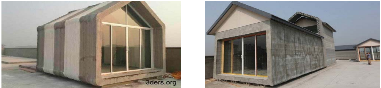
Рис. 1 – Дома в Китае, напечатанные на 3D принтере.
