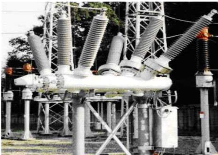
Рис. 5. Устройства PASS (Plug And Switch System)
