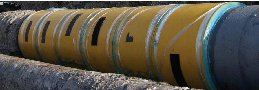
Рисунок 1 – Композитна ремонтна накладка, нанесена на трубопровід
