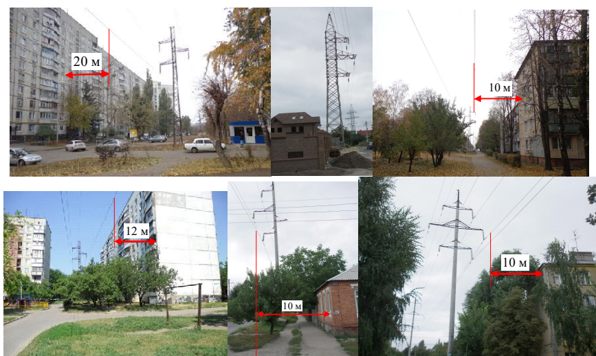
Рисунок 1.20 – Приклади розміщення трас ЛЕП 110 кВ поряд з житловими будинками у м. Харкові із порушенням санітарних норм
