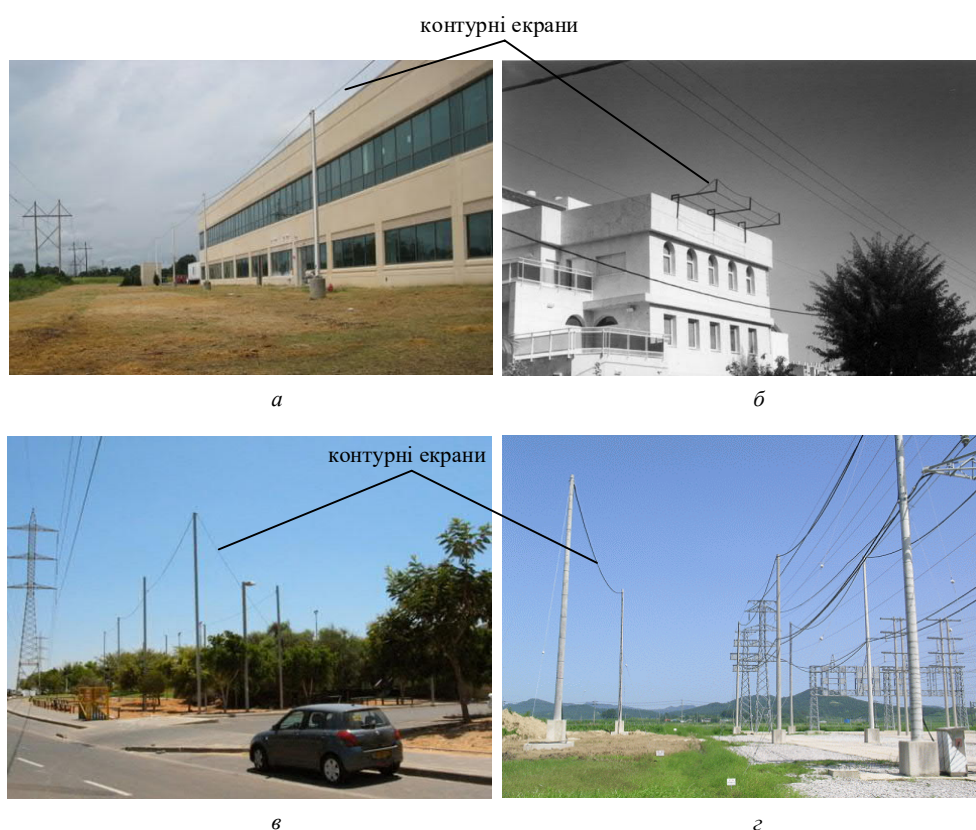
Рисунок 1.17 – Пасивні контурні екрани для безпосереднього зменшення МП ЛЕП
