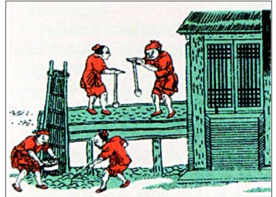
Рис. 1.42 - Трамбування глини під час будівництва Великої китайської стіни. Середньовічна китайська мініатюра
