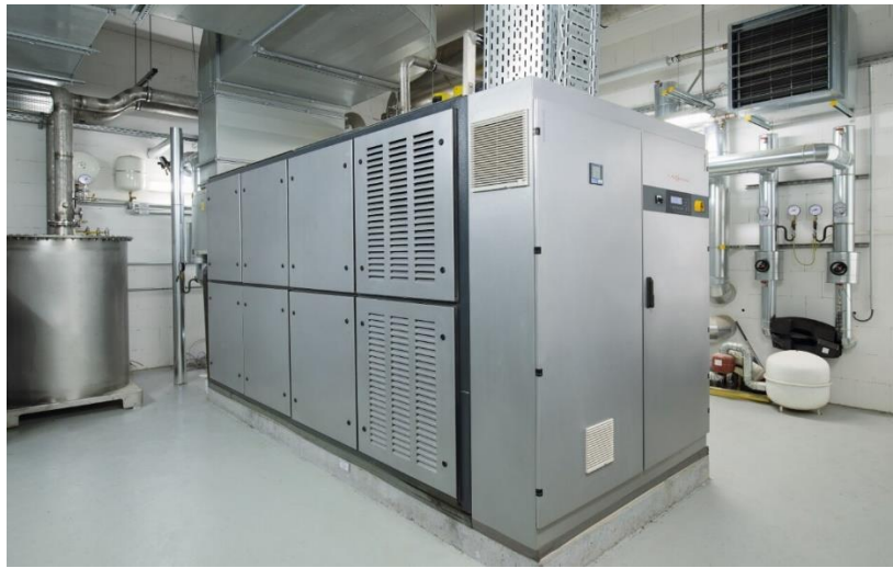
Рисунок 7.2 - Індивідуальна концепція для задоволення потреб готелю в теплі (когенераційна установка Vitobloc 200_EM-401)
