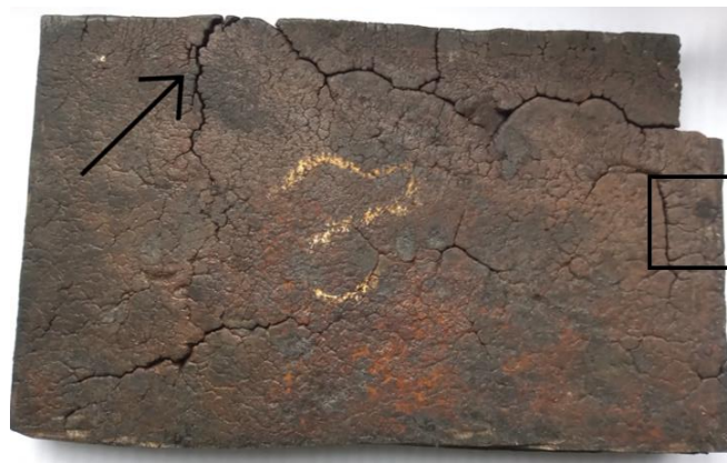
Рис. 1. Зовнішній вигляд ділянки плити гасильного вагона
