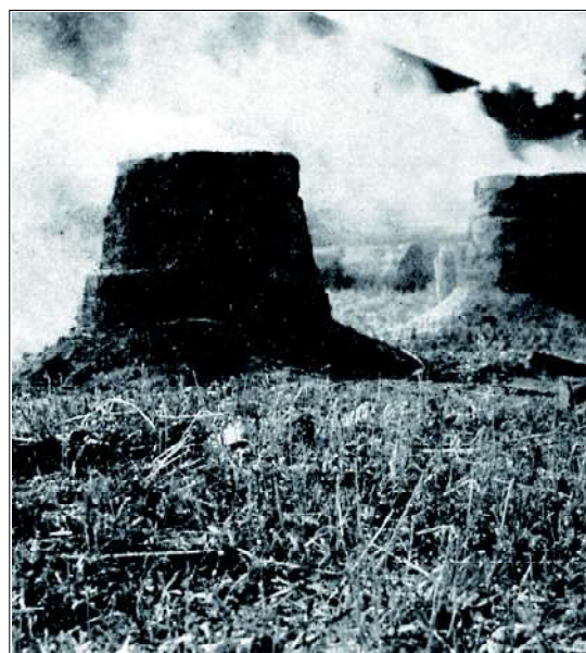
Рис. 3.8 - Виплавлення заліза в ямній печі з застосуванням поршневого повітродувного ступа. Малюнок з натури, зроблений у Центральній Африці (друга половина XIX ст.)
