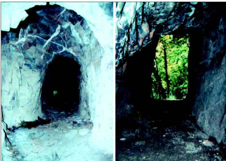
Рис. 3.53 - Гірничі виробки, споруджені римлянами, - траси водопостачальних каналів у Лас Медулас
