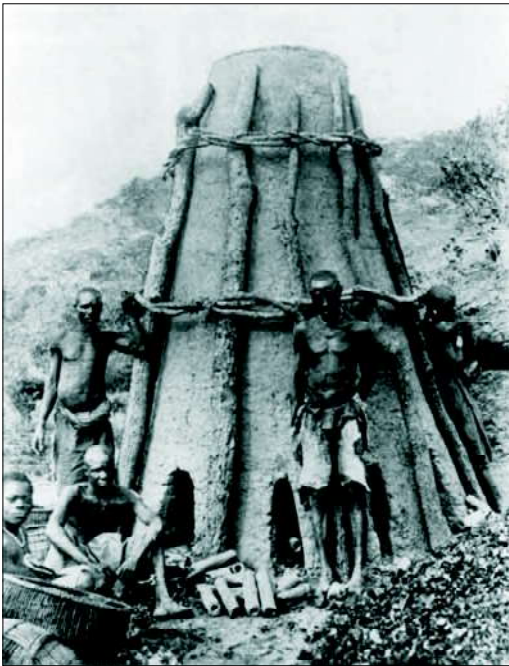
Рис. 3.10. Сиродутний конусний горн, що використовувався народом фіпа в Танзанії. Світлина початку XIX ст.
