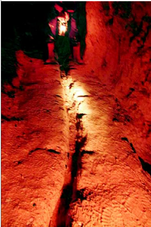
Рис. 3.58 - Гірничі виробки римських часів у Верошпатаці. Добре збереглися сходи похилої виробки та водовідливна канавка у штреку
