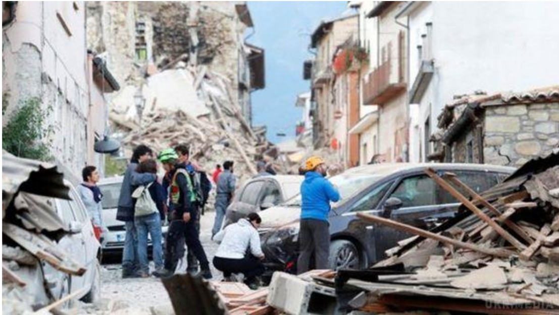
Рис. 3.10 Масштабні руйнування після землетрусу в Італії
