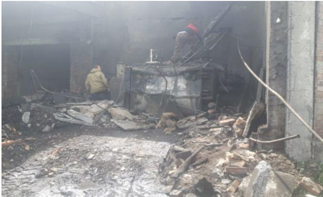
Рис. 1.2 Наслідки вибуху котла на молокозаводі
