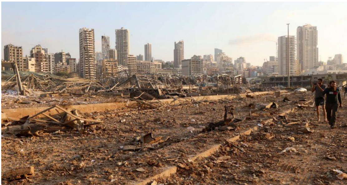
Рис. 3.11 Зруйнований вибухом Бейрут
