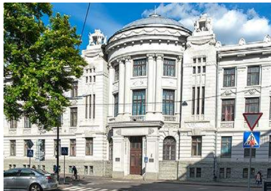
Рис. 6 ДУ «Інститут мікробіології та імунології ім. І. І. Мечникова НАМН України», м. Харків вул. Пушкінська, 14/16 (вигляд будівлі сьогодення).
