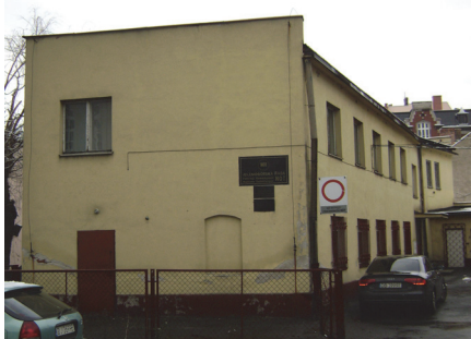
Rys. 6. Dom Technika w Jeleniej Górze
