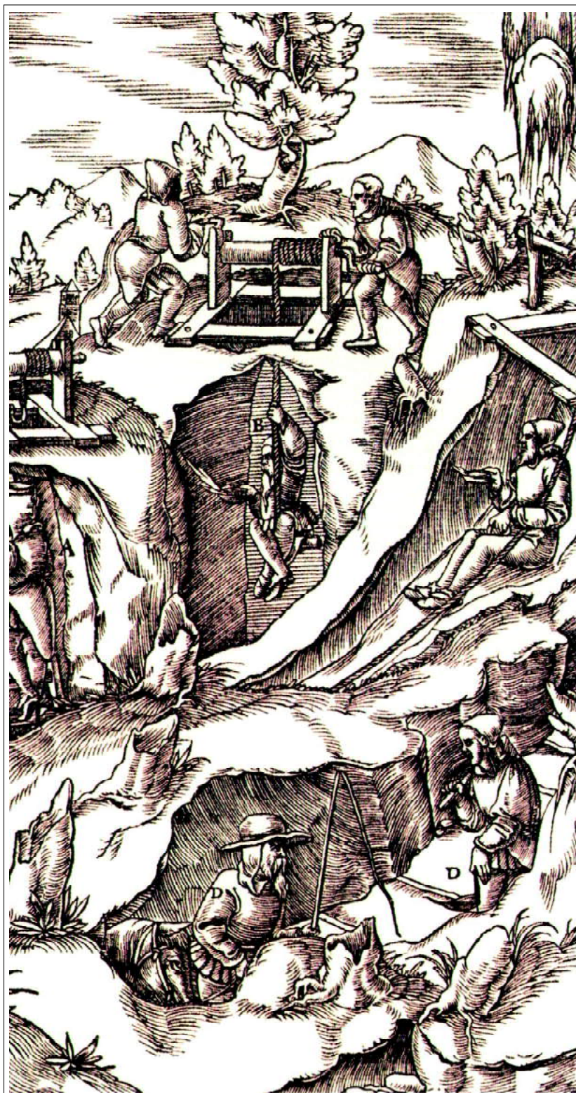
Рис. 4.102 - Спускання гірників вертикальним і похилим стовбурами. За Г. Агріколою
