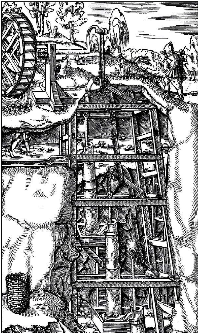
Рис. 4.92 - Система поршневих pomp з водним рушієм. За Г. Агріколою
