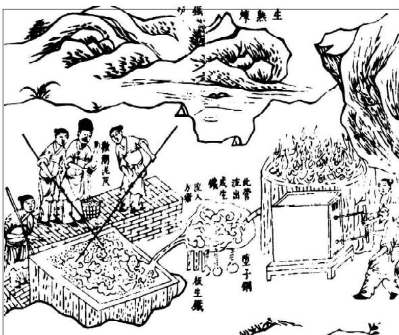
Рис. 4.123 - Процес пудлінгування в середньовічному Китаї. Ілюстрація з енциклопедії "Тянь гун кай у", 1637 р.
