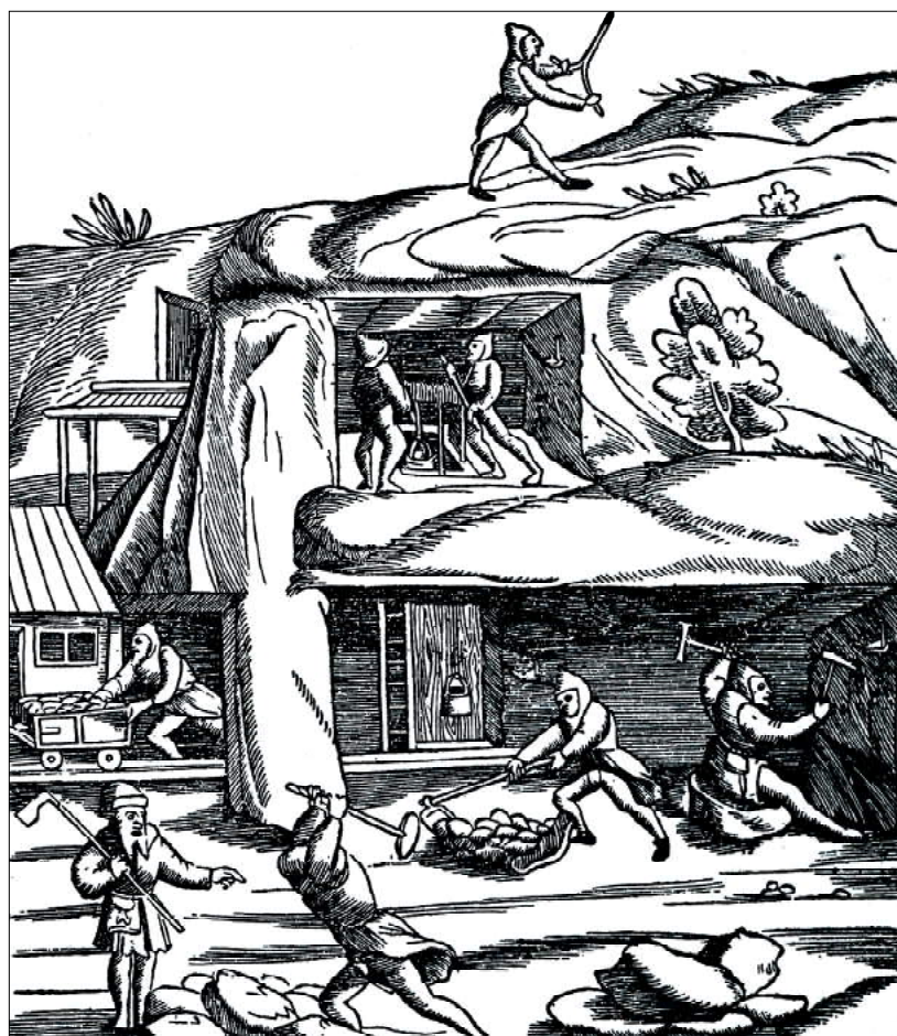
Рис. 4.106 - Гірничі роботи в руднику (за Г. Агріколою). Зліва - відкатка руди лежневою дорогою
