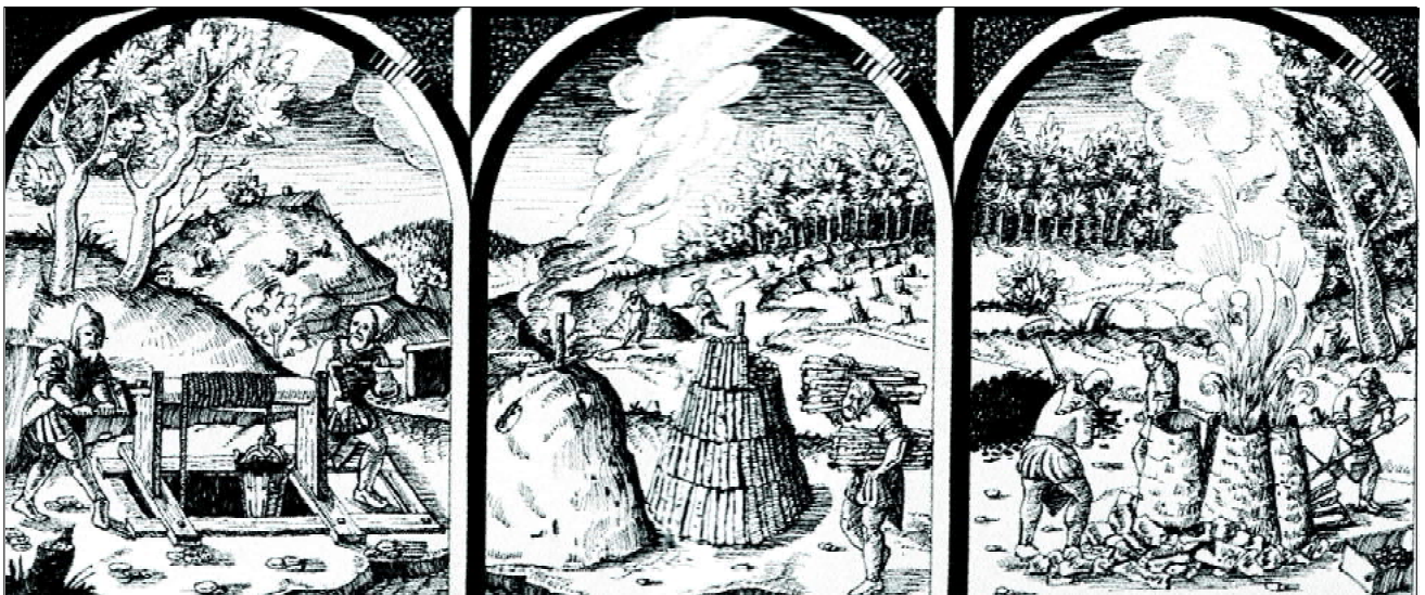
Рис. 4.159 - Підземний видобуток залізної руди, виробництво деревного вугілля та заліза середньовічними германцями (за Г. Аґріколою)
