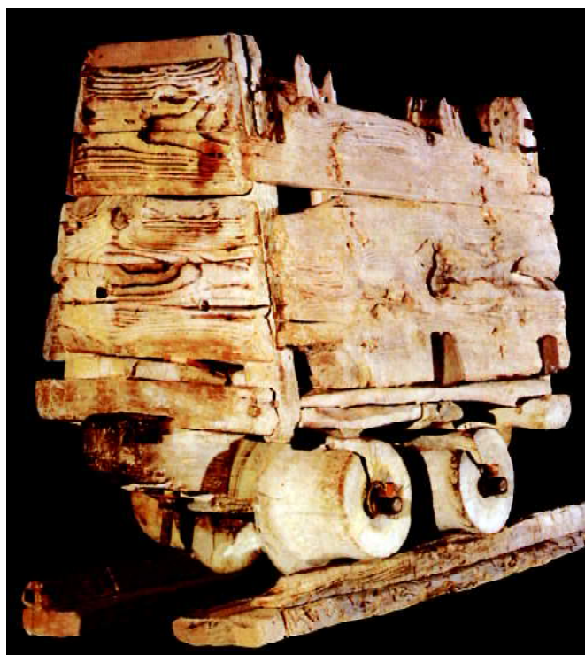
Рис. 4.108 - Оригінальний візок для відкатки руди дерев'яними рейками. Німецький гірничий музей у Бохумі
