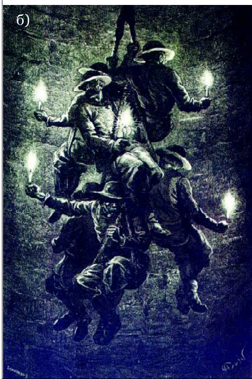
Рис. 4.101 - Спускання гірників у вертикальному стовбурі за допомогою канату: а - макет-реконструкція Словацького гірничого музею; б - гравюра Ж. Гослара (копальня солі Величка)
