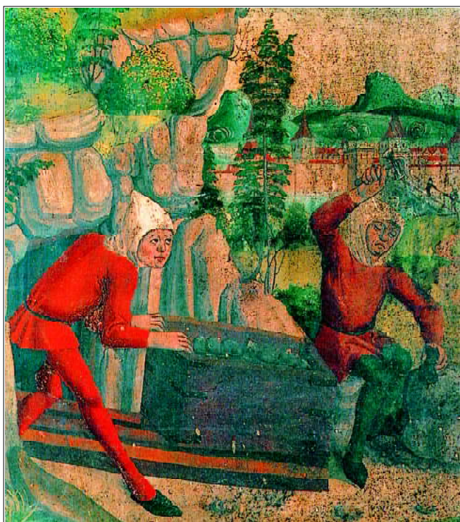
Рис. 4.107 - Транспортування візка з рудою лежневою колією (малюнок XVI ст.)
