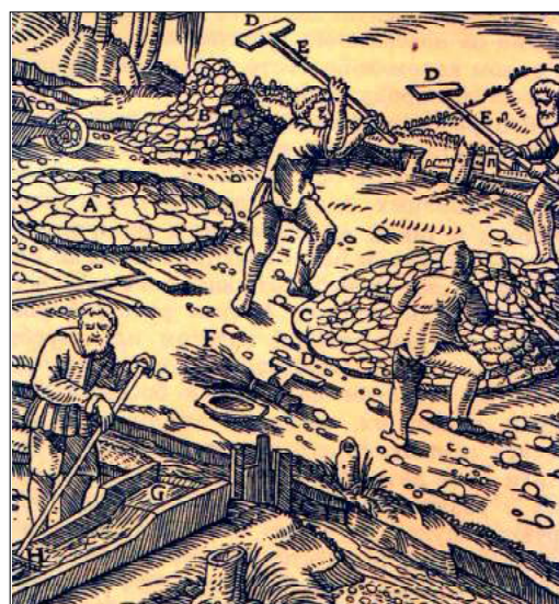
Рис. 4.116 - Подрібнення руди бияками (за Г. Агріколою)
