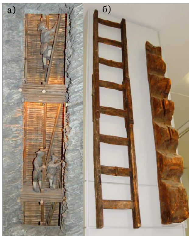
Рис. 4.99 - Драбинні сходи шахтних стовбурів: а - макет-реконструкція; б - оригінальне оснащення середньовічних виробок.
