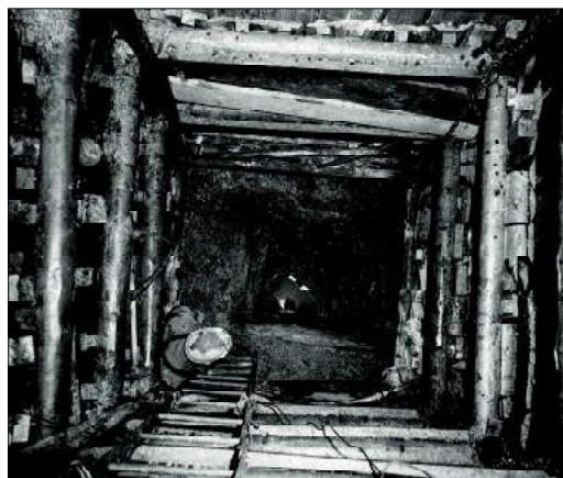
Рис. 4.164 - Відновлення середньовічного стовбуру на руднику Штальберг
