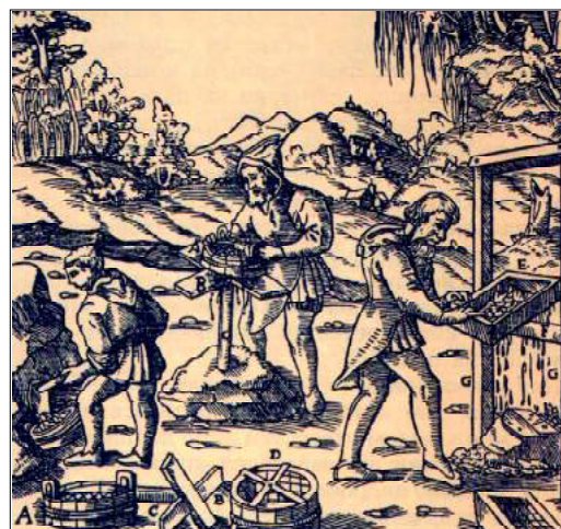
Рис. 4.115 - Сухе просіювання руди в рухомих ящиках (за Г. Агріколою)
