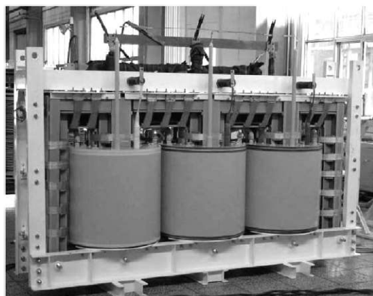
Рисунок 4.7 – Трифазний ВТНП трансформатор IEE / TBEA потужністю 630 кВА (10,5 кВ / 400 В)
