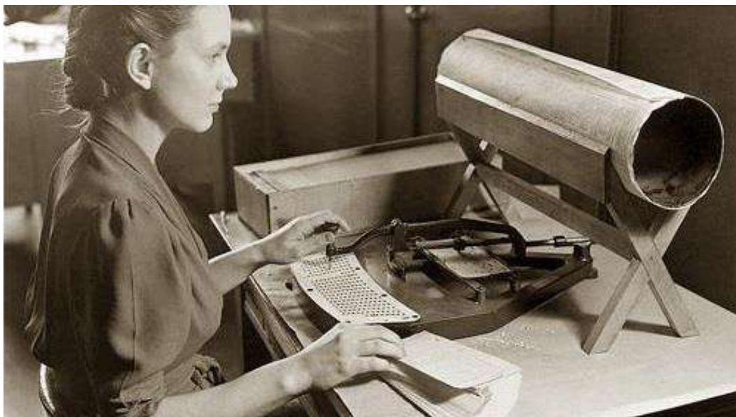
Рис. 7.22. Підготовка перфокарт за допомогою перфоратора Холлеріта
