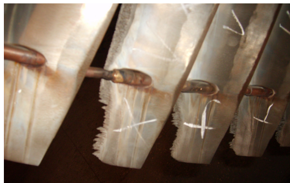
Рис. 1. Эрозионный износ рабочих лопаток турбины К-300-240 (наработка 35000 часов)
