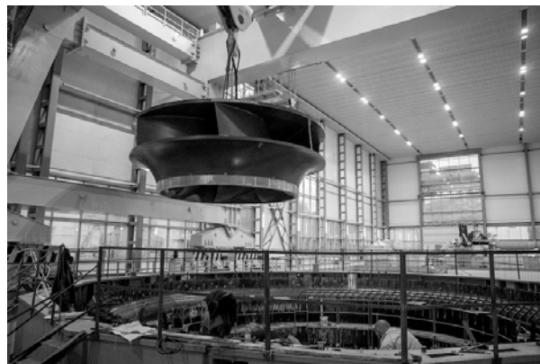
Рис. 2. Монтаж рабочего колеса Днестровской ГАЭС
