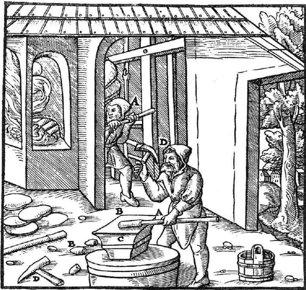
Пробірний залізний лист (A) з гострим сталевим кінцем. Тонка оболонка міді на ньому ("шкірка") B. Ковадло C. Молоток D.
