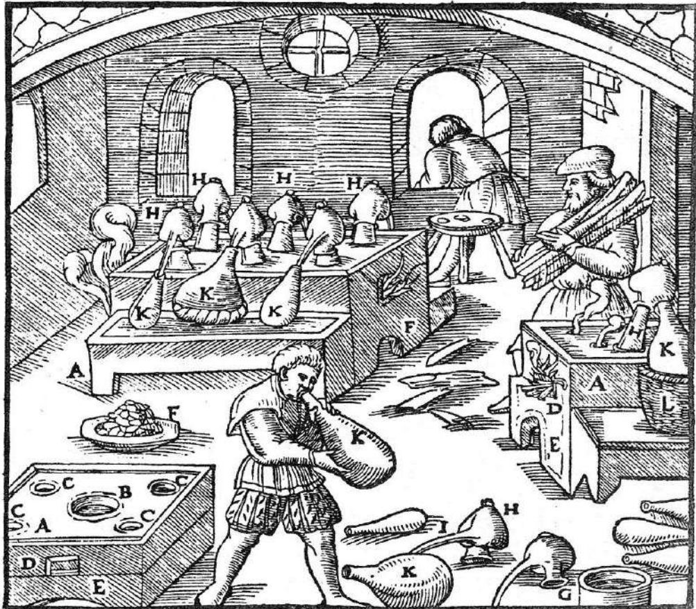
Піч A . Її круглий отвір B . Повітряні отвори C . Устя печі D . Повітряний отвір під ним E . Тигель F . Колба G . Кришка H . Носик I . Друга колба K . Кошик L , в якому розміщують колбу, щоб вона не розбилась.
