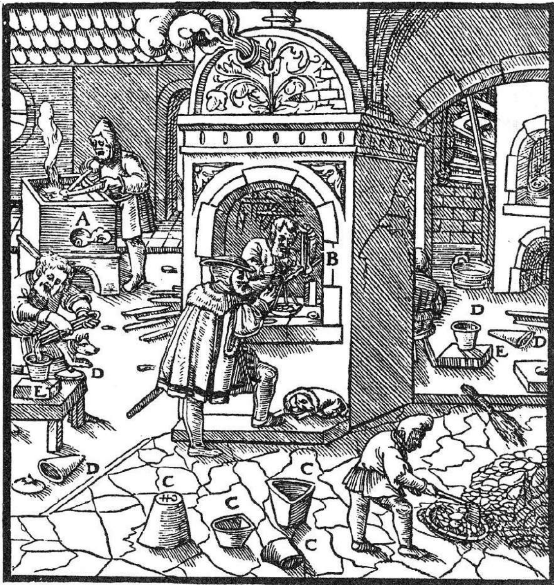
Піч, в яку повітря входить через отвори A . Золотоковальська піч B . Глиняний тигель C . Залізний тигель D . Колода E .
