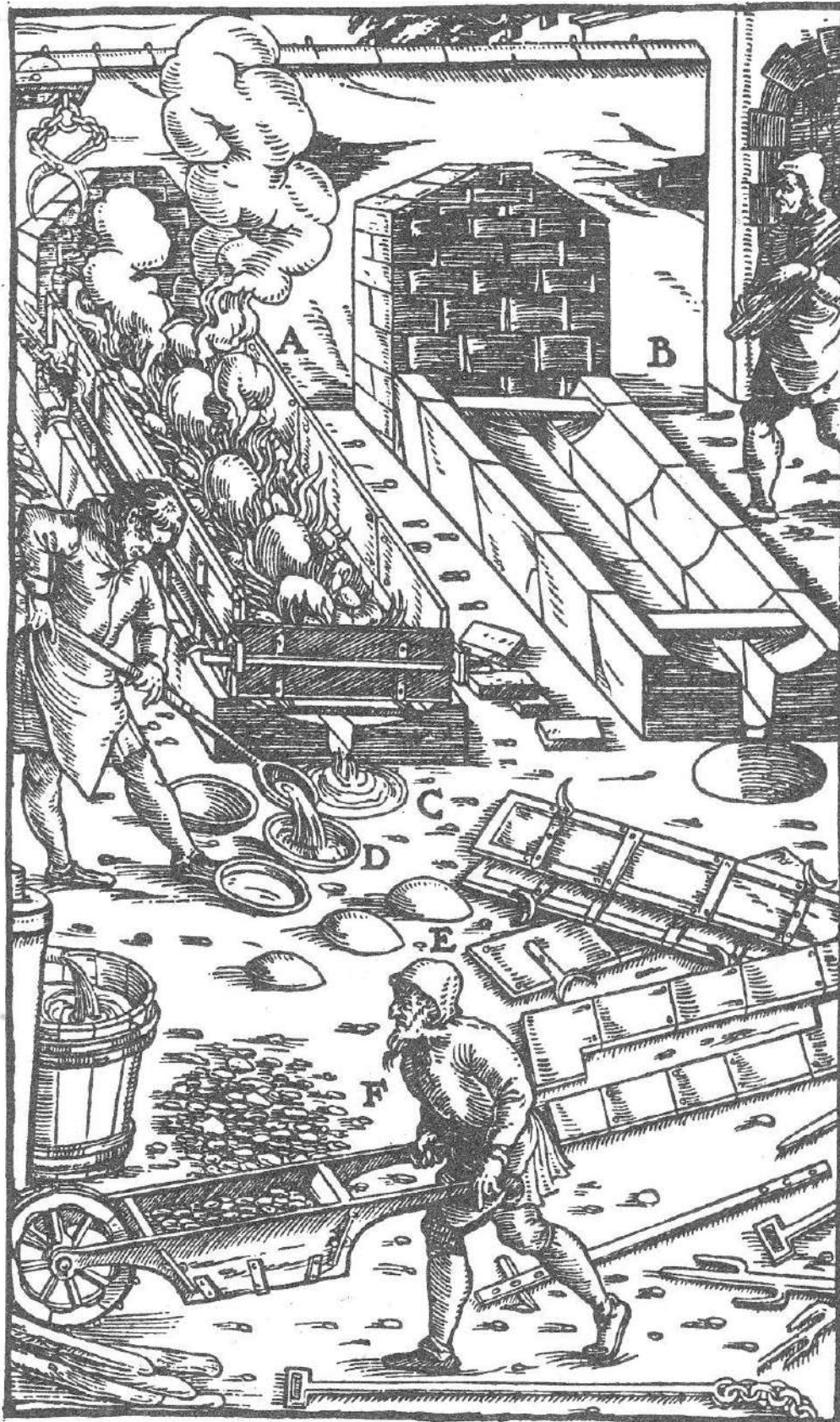
Зейгерна піч в дії A . Зейгерна піч, коли в ній робота не ведеться, B . Випускне гніздо C . Виливниці D . Кола зейгерблея E . Зейгерна креця F .
