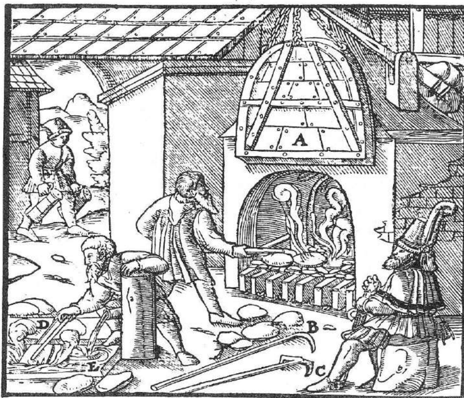
Підняті двері A . Гак B . Двозубі граблі C . Кліщі D . Чан E .
