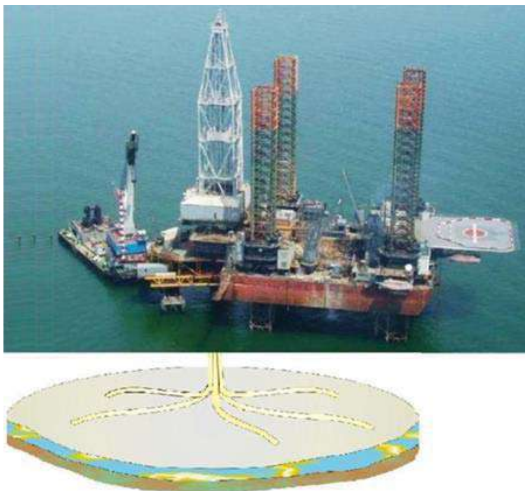
Рисунок 3.4 – Куц з п'яти свердловин із горизонтальними стовбурами на Східно-Казантипському родовищі (зміщення 750 м)
