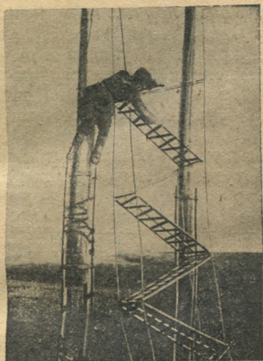
Рис. 3. Момент монтажа омического кабельного делителя на опоре линии передачи
