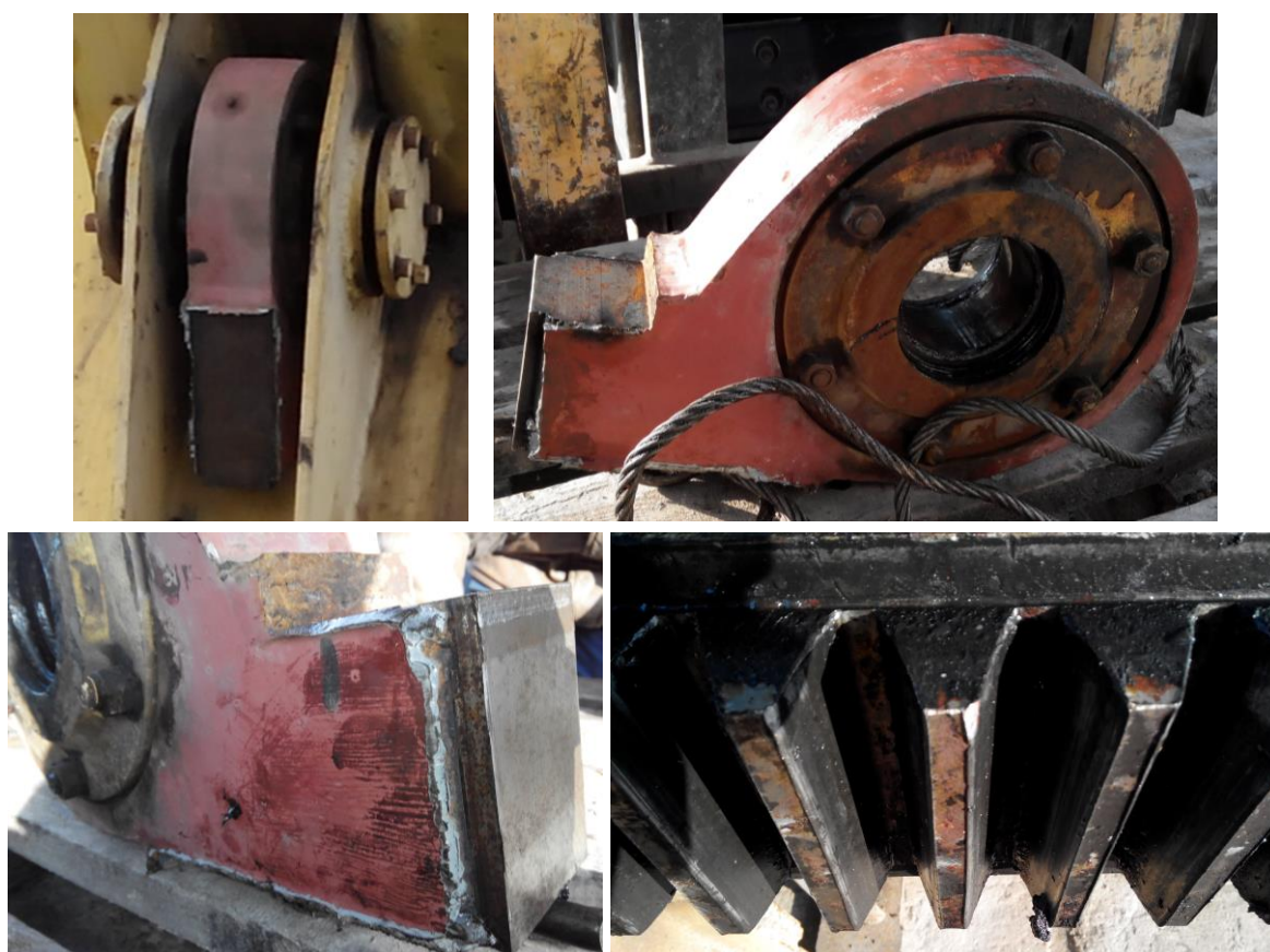
Рис. 2 – Характерные повреждения рейки механизма изменения вылета
