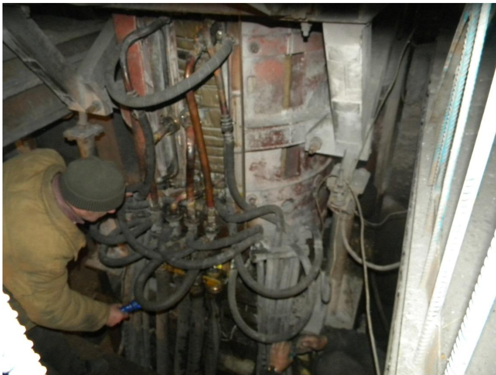
Рисунок 5.8 - Операції з обслуговування системи охолодження
