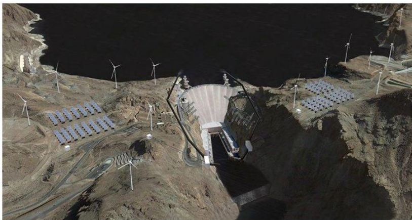
Рисунок 7 – Примерный вариант компоновки агрегатов и системы их управления для аккумуляции полученной ветровой и солнечной энергий
