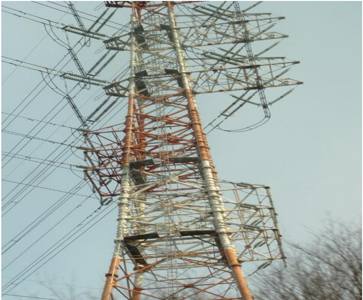
Рис.2.23. Комбінована повітряна лінія (Токіо. Японія)
