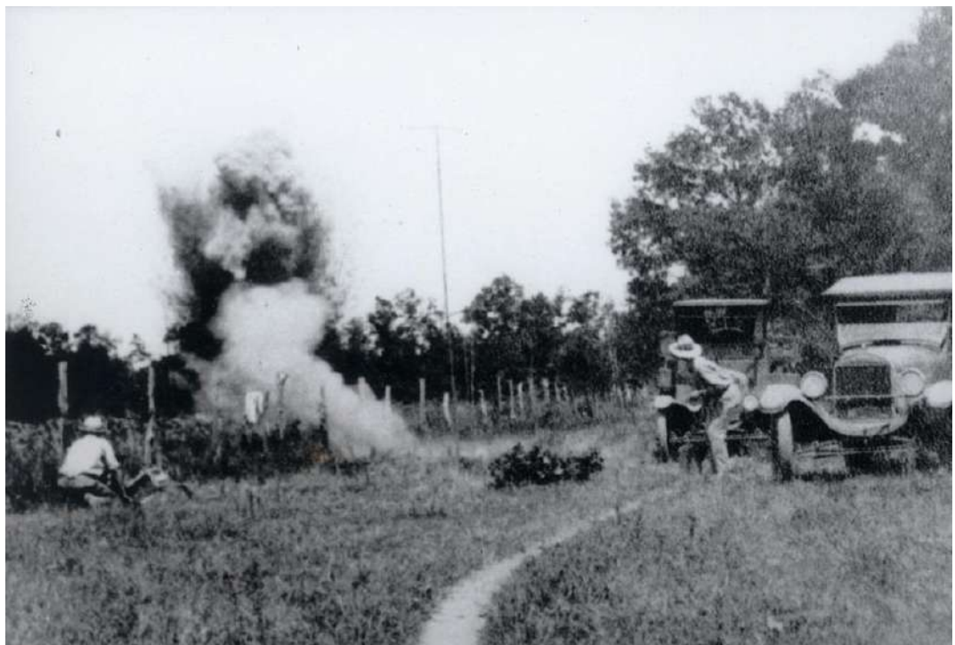
Рисунок 4.13 – Сейморозвідка методом заломлених хвиль у штаті Оклахома, США (компанія «Сеймос», 1923 р.)
