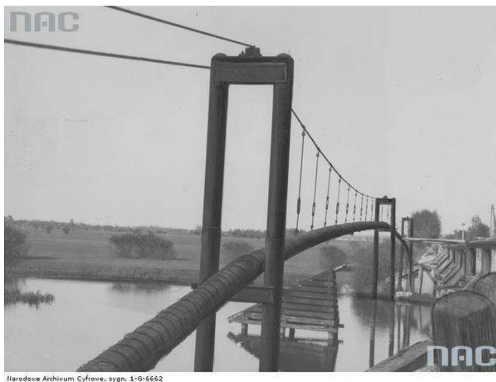
Рисунок 3.55 – Річковий перехід ділянки газопроводу «Дашава – Львів» (фото 1932 р.)
