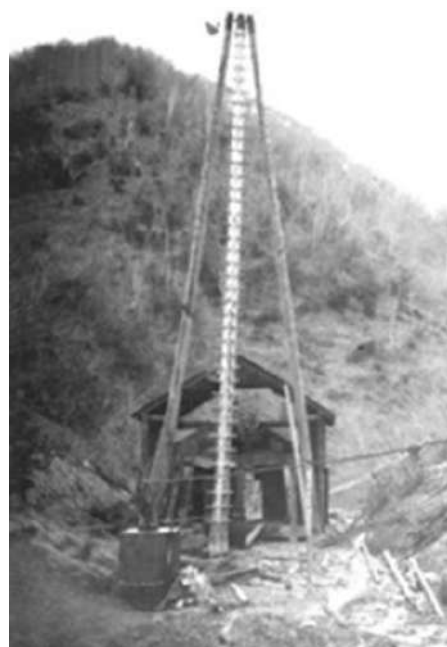
Рисунок 2.6 – Один з піонерів нафтової промисловості І. Лукасевич та тринога для ударного буріння свердловин, яку він використовував з 1854 р.
