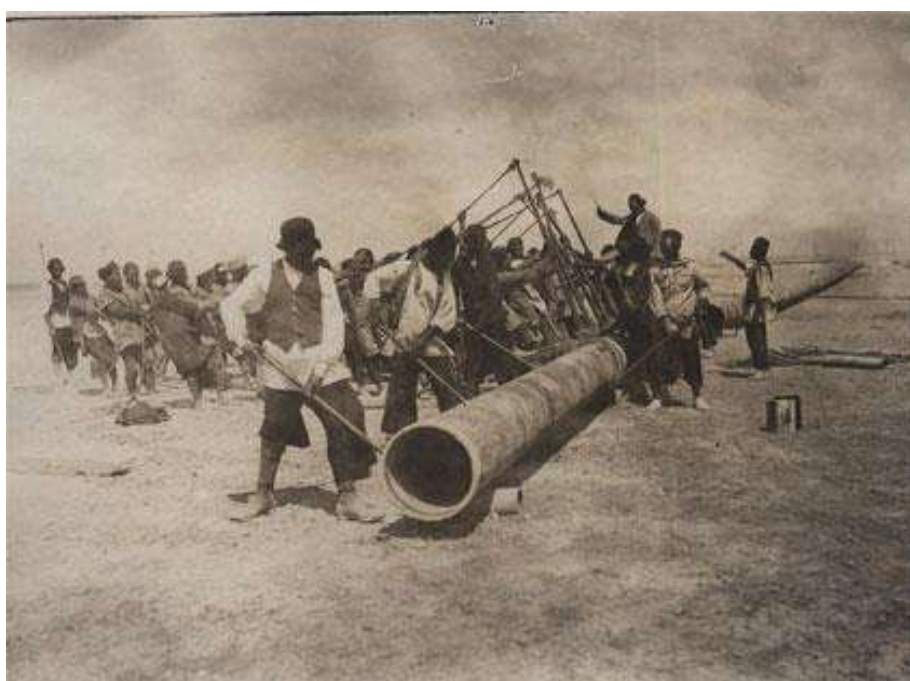
Рисунок. 3.3 – Доставка труб та монтаж нафтогону в південно-західній Персії (1910-ті роки)
