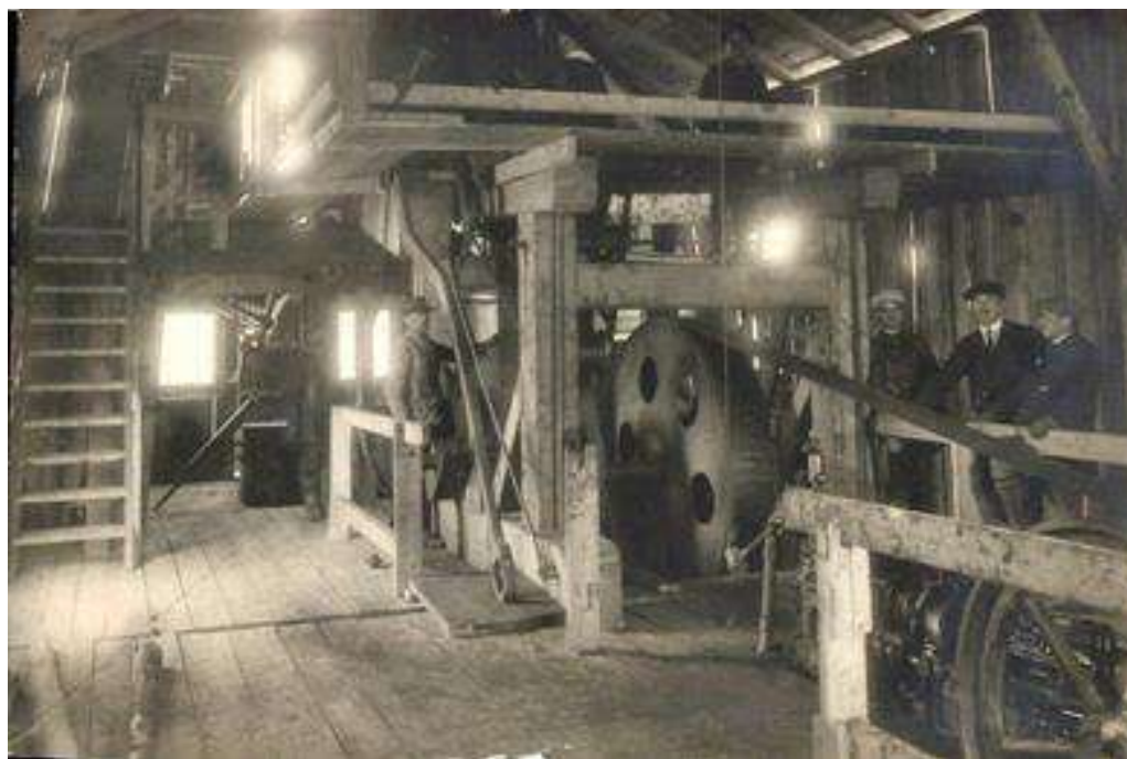
Рисунок 2.9 – Будівництво нафтових веж у Галичині та «шиба» в середині (світлини кінця XIX ст.)
