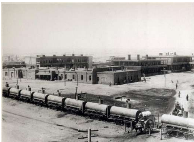
Рисунок 2.36 – Вагони-цистерни та циліндричні сховища В. Шухова, розроблені для компанії «БраНобель»
