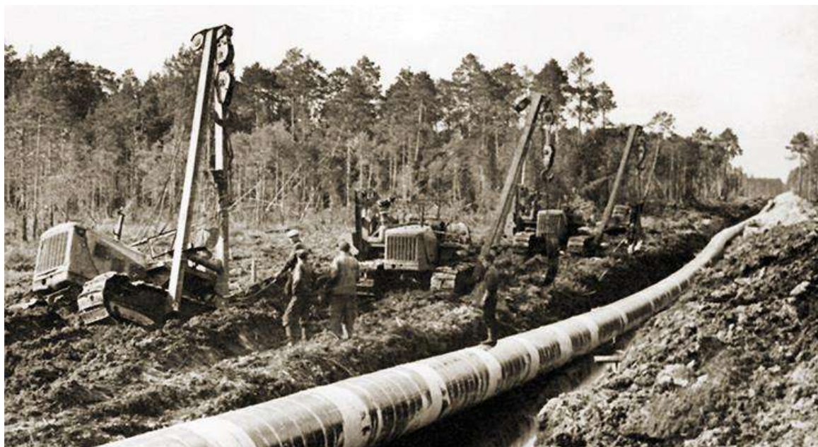
Рисунок 3.44 – Будівництво першого сибірського газопроводу Шаїм-Тюмень
