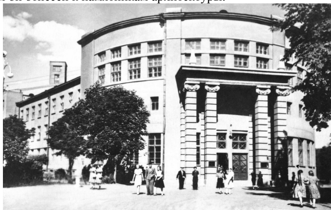
Электрокорпус в наши дни
