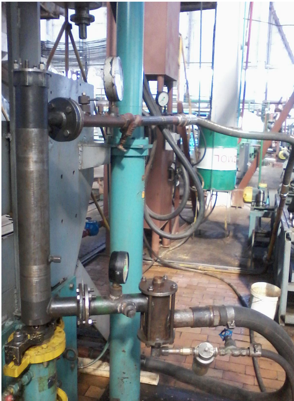
Рисунок А.1 – Монтаж ЛГН в експериментальний стенд
