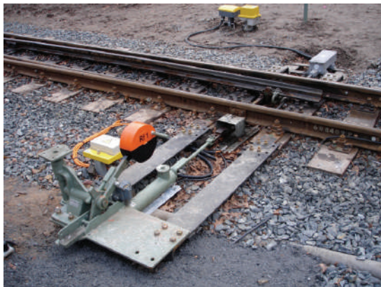
Рисунок 1.3 – Ручний стрілочний привод допоміжної колії
