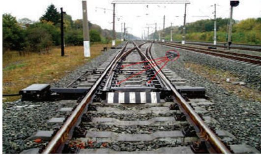
Рисунок 1.33 – Місце установки роликівих вузлів на СП Дн300.00.000.
