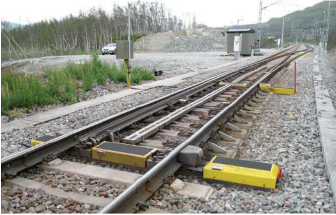
Рисунок 1.22 – Стрілочний перевід Easyswitch-R
