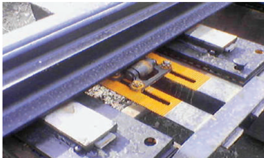
Рисунок 1.34 – Загальний вигляд підтримуючого ролика
