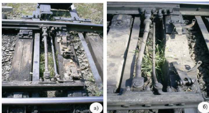
Рисунок 2.23 – Деформації зв'язної тяги: а – рівна тяга; б – вигнута тяга
