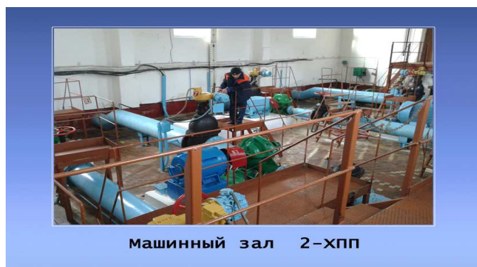
Рисунок 3 – Насосная станция
