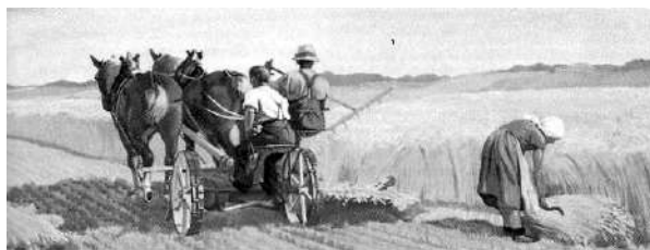
Рис. 10. Кінна жатка-косарка з пристроєм для укладання стебел у купки
