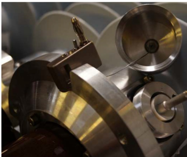
Рисунок 1.19 – Вимірювальний вивід зі знятим ковпаком
